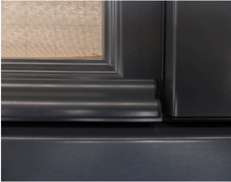
Jet d'eau profil doucine Moulures adaptées au bâti ancien
