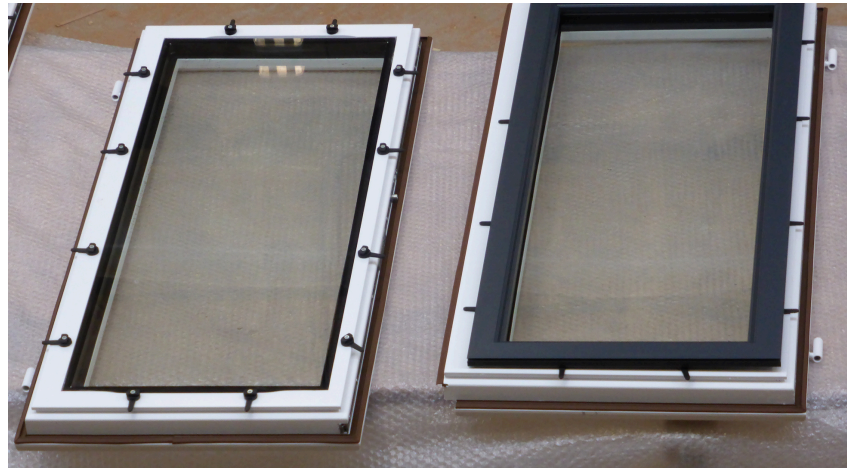
Capotage en aluminium fixé par clameaux
